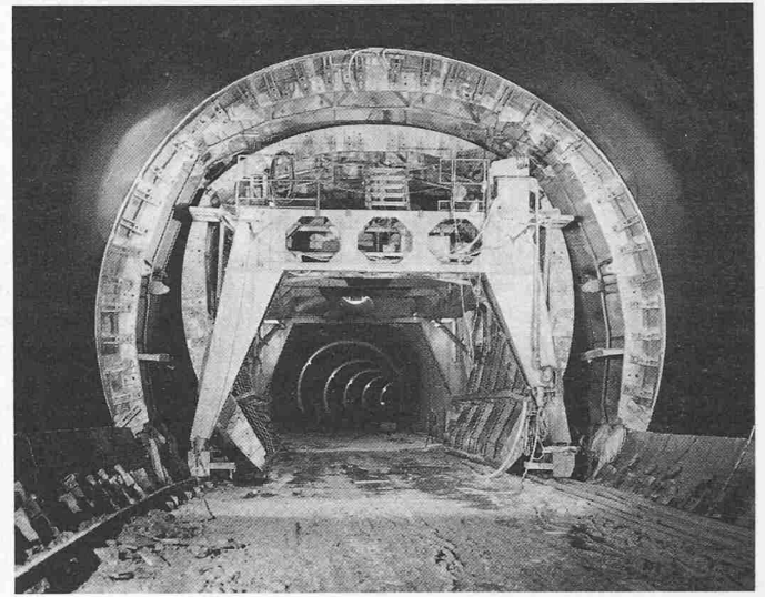
Bild 6. Los Ost. Schalwagen zum Betonieren des Innengewölbes nach dem Aufbringen der elastischen Isolation
