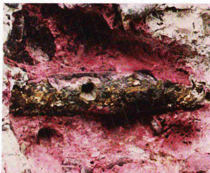
Brücke C. Der untere Drittel dieses Armierungseisens wurde durch die Karbonatisierung erreicht und die beginnende Oxidation bewirkt bereits eine Trennung von Eisen und Beton
