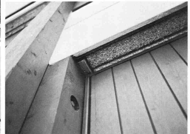
Detail Mehrzweckhalle, Haag SG
