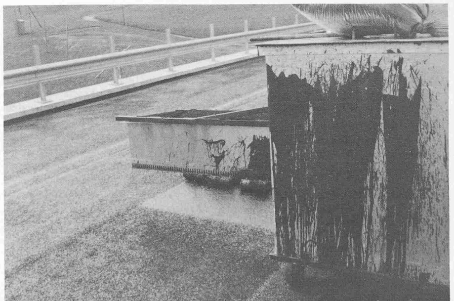
Bild 15. Maschinelles Einstreuen von Gummigranulat als Haftvermittler
