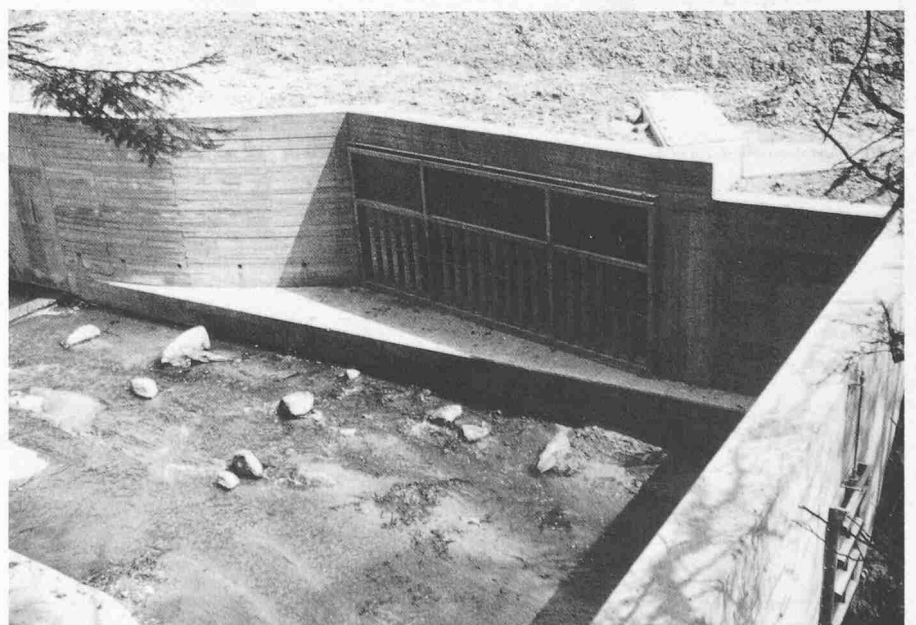
Bild 6. Einlaufbauwerk mit Überlaufschwelle und Rechen
