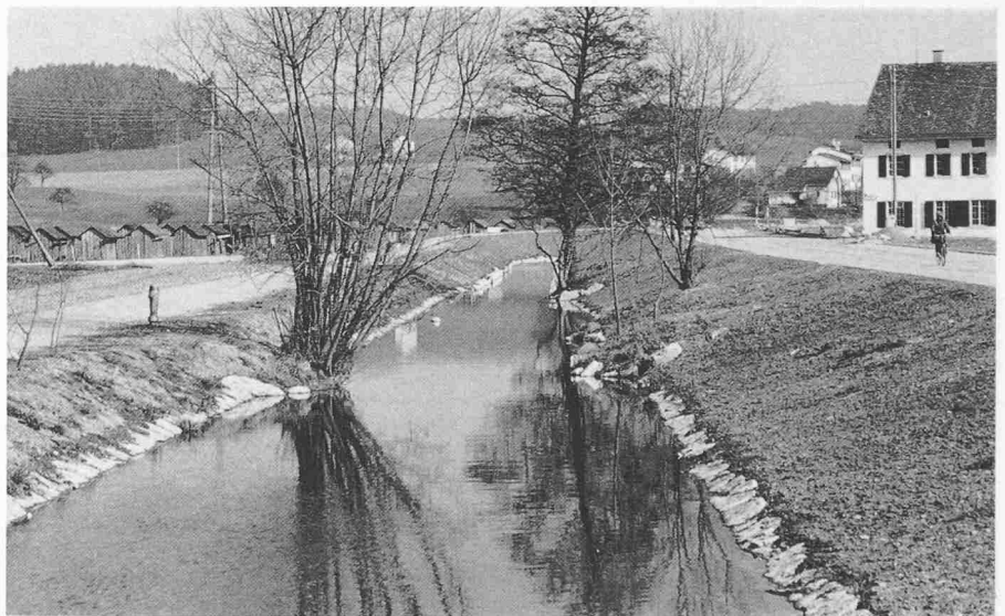
Bild 2. Eulach unterhalb Verzweigungsbauwerk. Links der neu gestaltete, entlastete Eulachlauf für Q = 15 \text{ m}^3/\text{s} im Staubereich des Wehres «Mühle Hegi». Unter der Umfahrungsstrasse (rechts) der Hochwasserkanal
