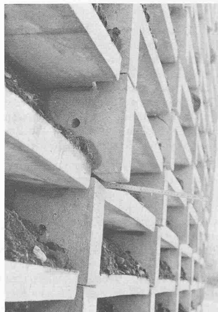
Bild 2. Verschiebung der Binderelemente. Aufnahme vor Abbruch der Mauer
