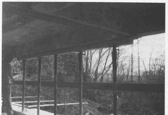
Bild 7. Anpressen der Bleche an den Konstruktionsbeton. Mit den Deckenspriessen und dem Kantholz wird ein gleichmässiger Anpressdruck erreicht. Die Spriessen stützen sich auf dem Gerüst ab, das mit Ketten an der Brücke befestigt ist
