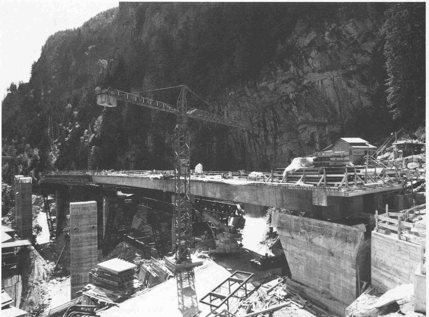
Stand der Arbeiten am 23. Juli 1980
