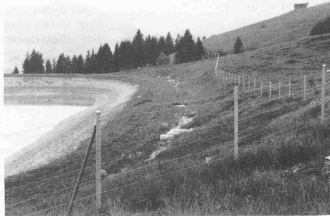
Bild 10. Ausgleichsbecken Gneida, Hangseite. Einige Jahre nach Inbetriebnahme. Die frühere Abrisskante der Rutschung liegt am rechten Bildrand. Auf der Berme in Bildmitte sind einzelne Brunnenschächte der Entlastungsbrunnen zu erkennen
