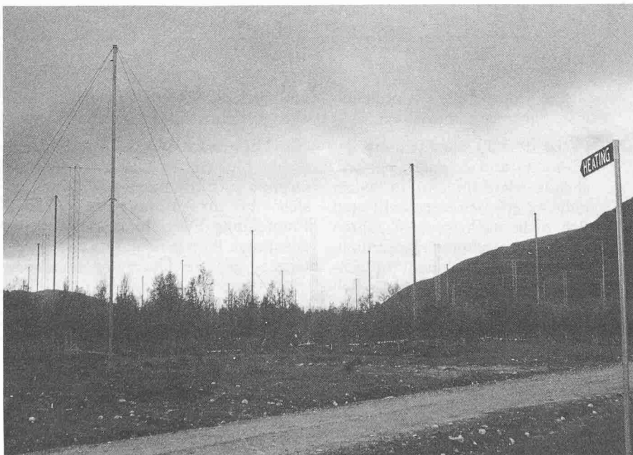
In einem weitläufigen Birkenhain des Ramfjordmoen-Tals steht ein «Wald» von Antennen: Die gekreuzten Dipole der Heating-Sendeanlage. Jedes Antennenfeld umfasst 36 gekreuzte Dipole, und drei Antennenfelder stehen zur Verfügung. Durch Phasensteuerung lässt sich die Richtung des Sendestrahls schwenken
