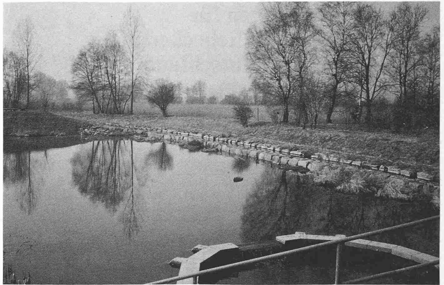
Fischbach bei Niederglatt/Neerach. Beispiel eines Hochwasserrückhaltebeckens mit einseitiger Überflutungszone (Neeracher Ried), kombiniert mit Hechtteich
