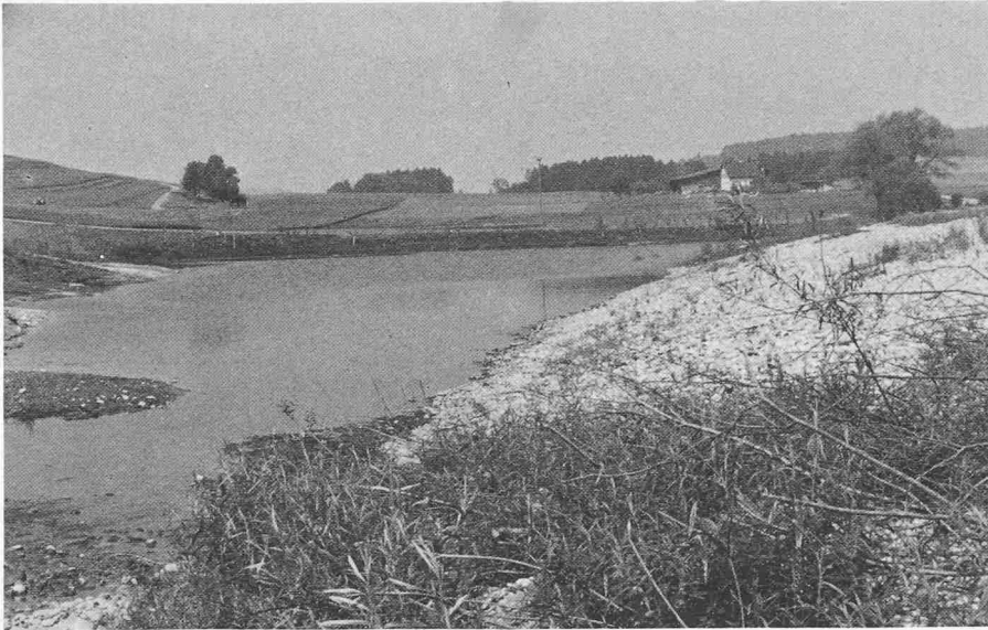
Hochwasserrückhaltebecken Chefikon an einem Seitenfluss der Thur bei Ellikon a. d. Thur (ZH). Übersicht
