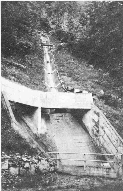
Bild 9. Chellbach. Ortbetongerinne mit hundertprozentigem Gefälle und Kiessammler
