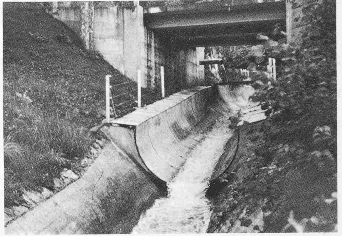
Bild 8. Mühlebach. Übergang Ortbetonschale zu Wellblechschale mit Werkstrassenbrücke
