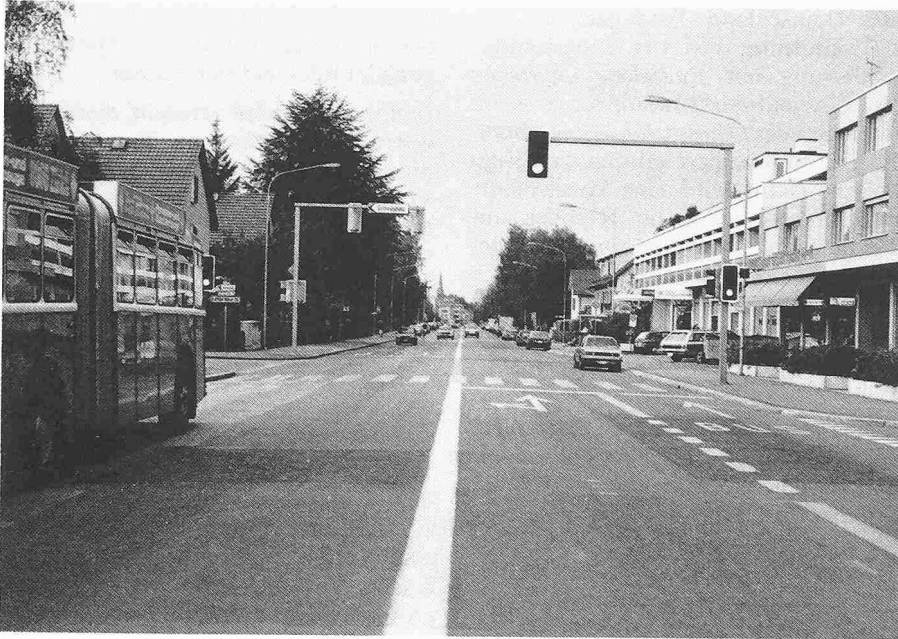
Bild 5. Das «Landstrassen-Denken» zerstört die Wohnlichkeit. Die überrissenen Ausbaunormen, die für diese Strasse zur Anwendung kamen, erzeugen eine Monotonie, die zum schnellen Fahren einlädt und entsprechende Gefährdungen und Emissionen zur Folge hat. Die Schwerpunkte der Kommunikation – Läden, Schulen, Gaststätten, usw. – werden durch die Strassenfläche von allem getrennt, kaum verbunden
