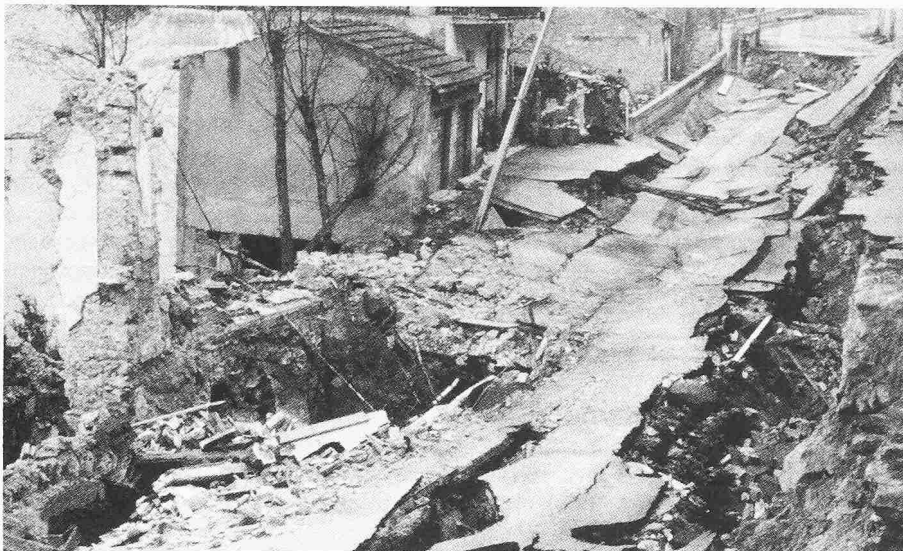
Bild 2. Strassenschäden in Calitri
