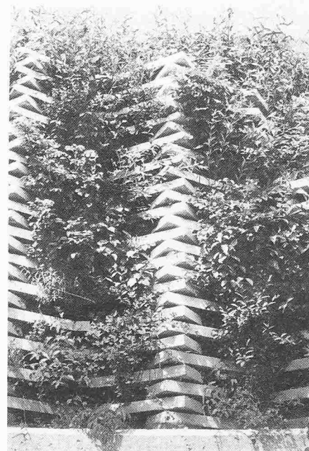
Bild 4. Sternelementmauer mit Heckenbuschlagen fünf Monate alt
