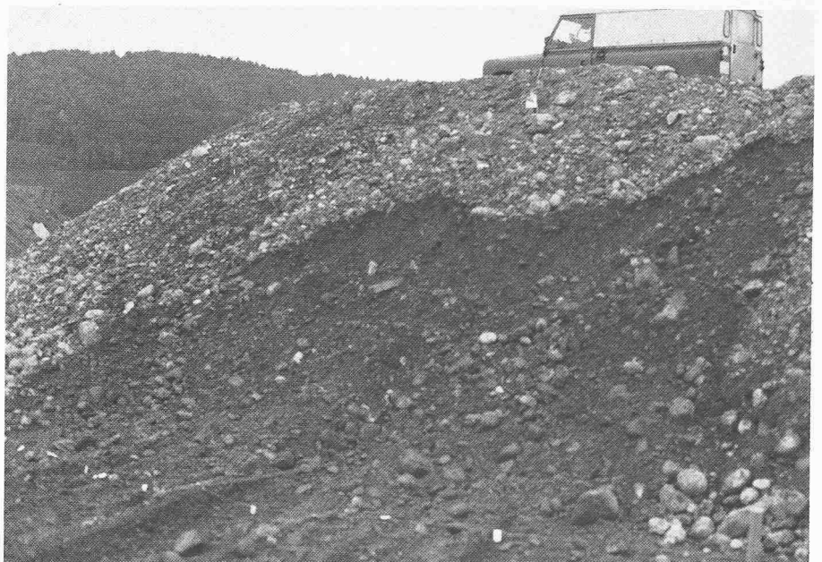
Bild 5. Hang nach der zweiten Hangfussentlastung
