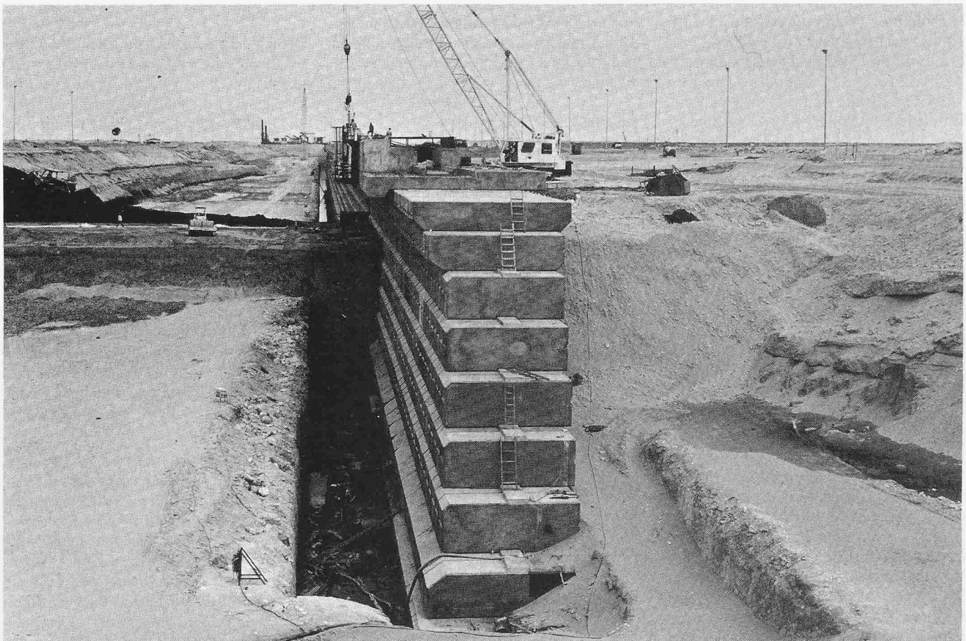
Bild 18. Hafenanlage Jebel Ali. Total 1,5 Mio. m³ Beton
