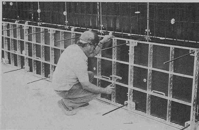
Verbinden der einzelnen Tafeln untereinander mit Stossklemmen
