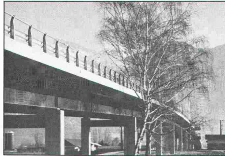
Strassenbrücke in Verbundbauweise Stahl/Beton
