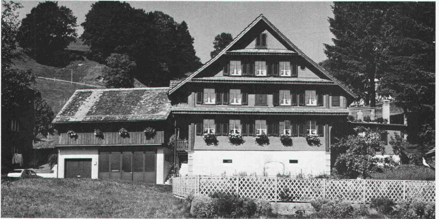
Bauernhaus in Oberägeri, Rundschindel-Deckung 7,5×30 cm, Rehbraun
