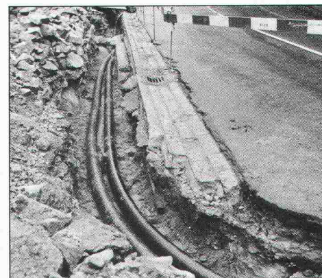
11.55 Komplett verlegt – 360 m nahtlose Fernwärmeleitung – Ziel erreicht!
