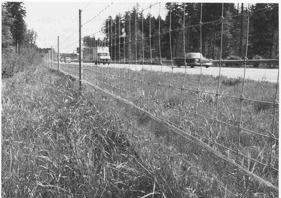
Zäune trennen einst zusammenhängende Lebensräume auf. Während die grossmaschigen Gitter vor allem Schalenwild aufhalten sollen, verhindern die engmaschigen den Übertritt von Amphibien und Kleinsäugetern. Allerdings sind diese Vorkehrungen häufig ungenügend, denn immer wieder kommt es zu Kollisionen zwischen Auto und Tier
