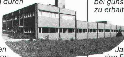
Industriebau in Liestal, BL. Neubau mit Kunststoff-Fenstern.
