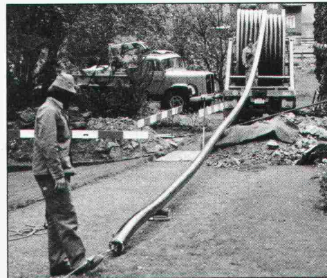
10.04 Die Verlegung der FLEXWELL-Leitung beginnt...
