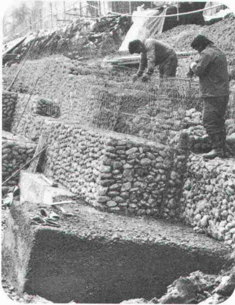
Baustelle SKA, Giesshübel Zürich
