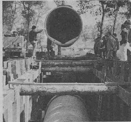
Die Elemente sind mit einer Druchlaufrinne, bestehend aus Drittelschalen und Eterplacplatten, ausgestattet
