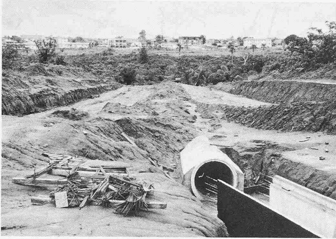
Bild 18. Hauptsammelleitung in Neu-Owerri
