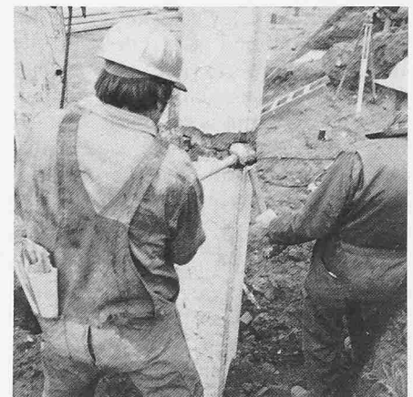
Bild 8. Einsetzen der vier Keile
