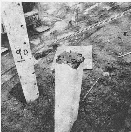
Bild 6. Unterer Pfahlschuss eingerammt
