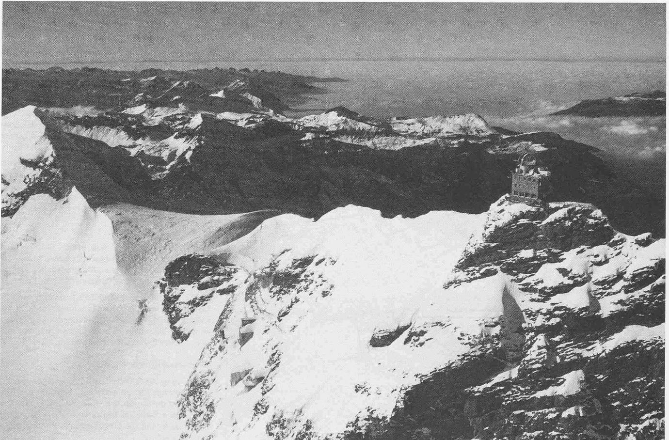
Das Jungfrauoch mit Observatorium und Sphinxgrat. In der Bildmitte unter der Felspartie das Gletscher-Restaurant und der Standort für das neue Berghaus
