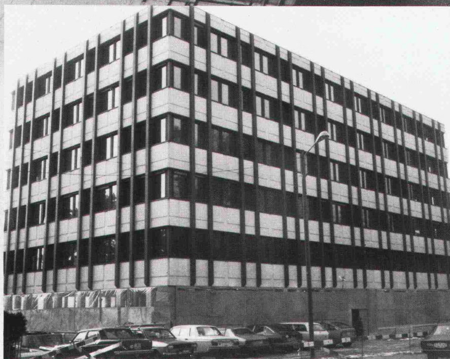
Verwaltungs- und Geschäftsgebäude der Publicitas AG, Lausanne. Dieses Bauvorhaben war bei der WAADT versichert.
