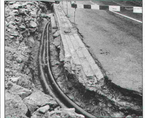
11.55 Komplett verlegt – 360 m nahtlose Fernwärmeleitung – Ziel erreicht!
