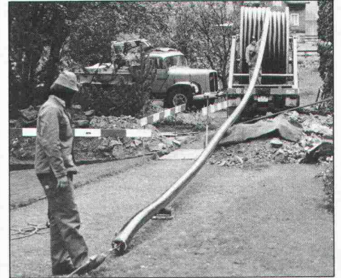
10.04 Die Verlegung der FLEXWELL-Leitung beginnt...
