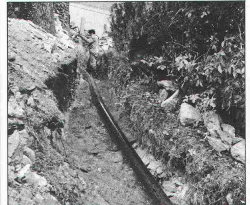
10.45 Die erste Länge ist verlegt...
