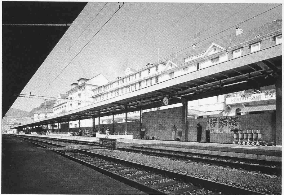
Bild 2. Der neue Aussenperron, links das neue Zentralstellwerk
