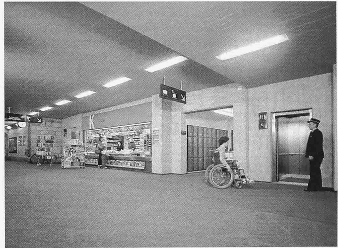
Bild 8. Olten: sanierte Personenunterführung Süd (Teilansicht)
