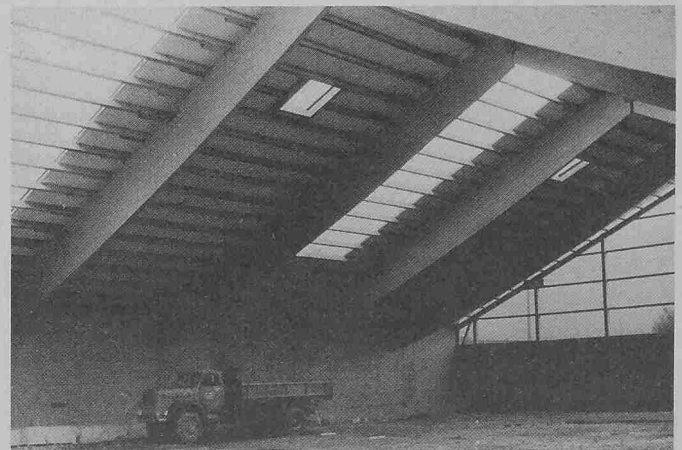
Tennishalle Bad Ragaz mit Gantner Isolier-Unterdach
