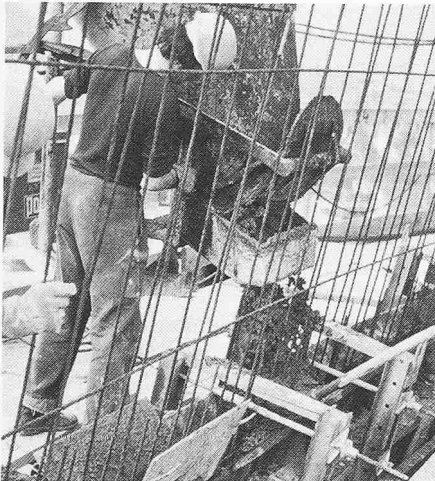
Bild 13. Einbringen von Beton
