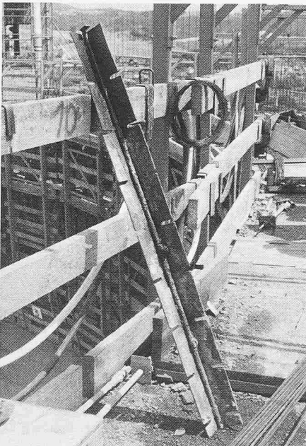
Bild 15. Kammartiges Stahlblech für lotrechte Arbeitsfuge
