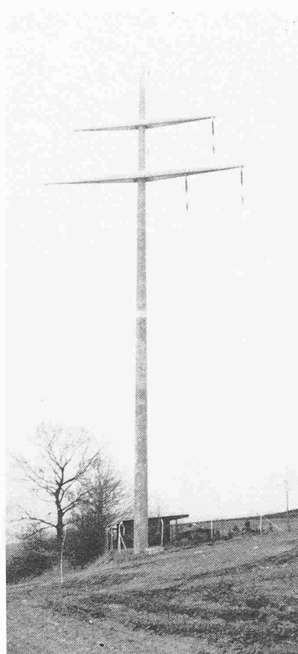
110-kV-Doppelleitung (Tragmast, L = 36-40 m)
