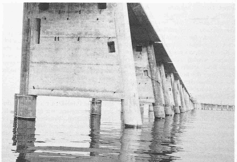
Pfähle für die Hafemole Arbon
