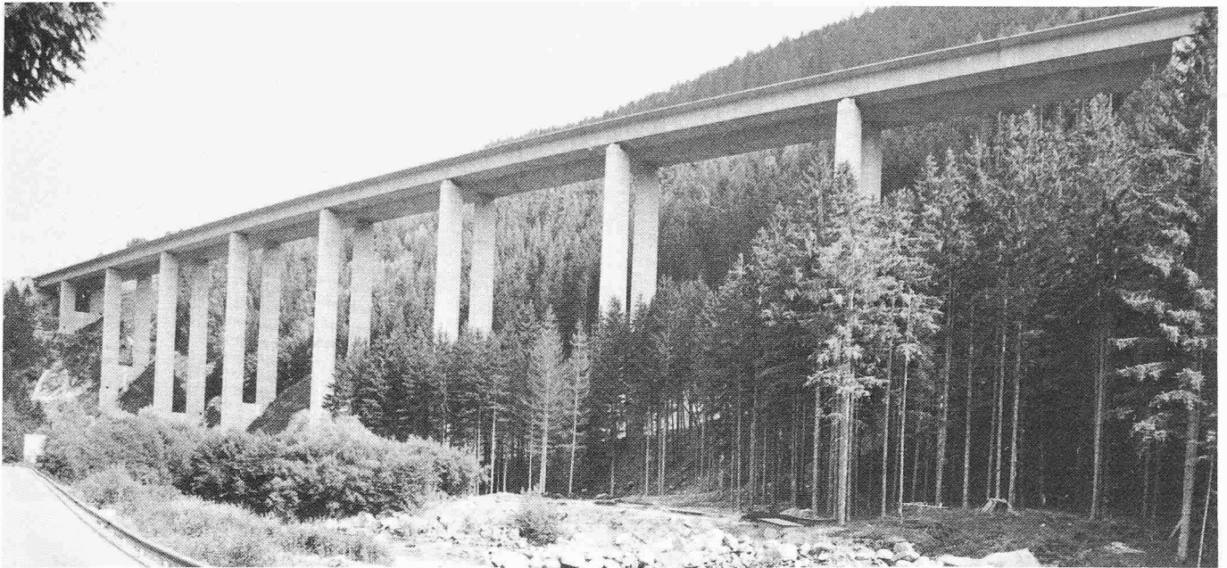
Bild 1. Die 1167 m lange Hangbrücke Puchreit mit Spannweiten von 55 m und Pfeilern bis zu 80 m Schaftlänge – die erste Brücke Österreichs in Segmentbauweise
