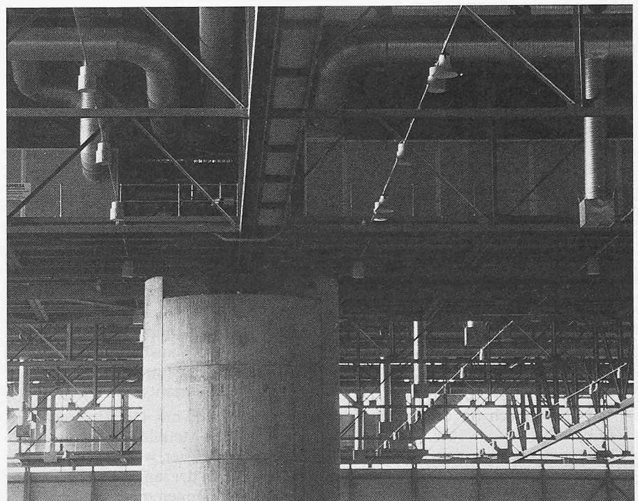
Fertige Stahlkonstruktion im Bereich eines Auflagerturms
