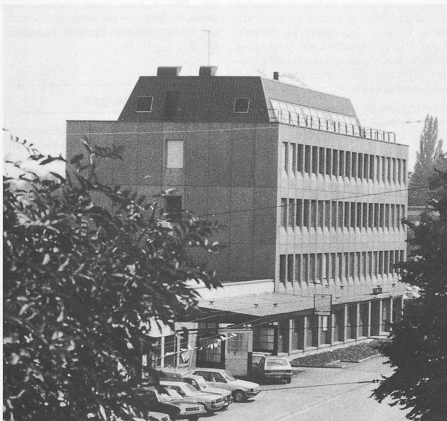
Bild 1. Aussenansicht des Bürotraktes. Sonnenkollektoren in Dach integriert
