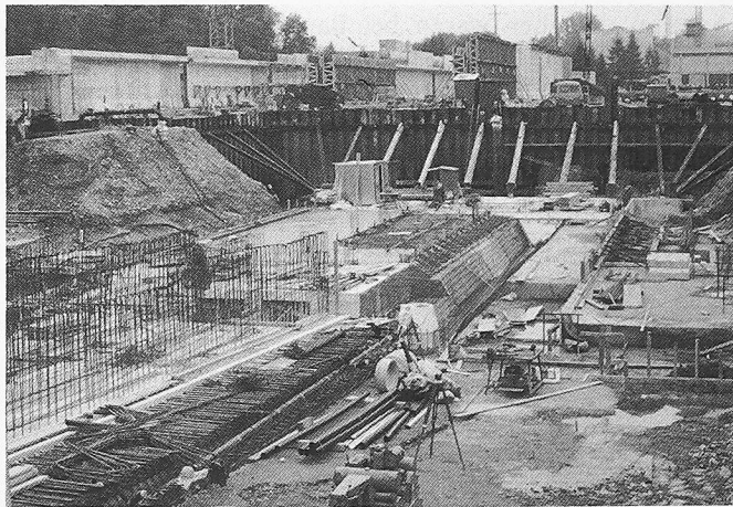
Bild 9. Baugrube des Filtergebäudes (Los 4), das als einziges Objekt 8 m tief ins Grundwasser hineinreicht
