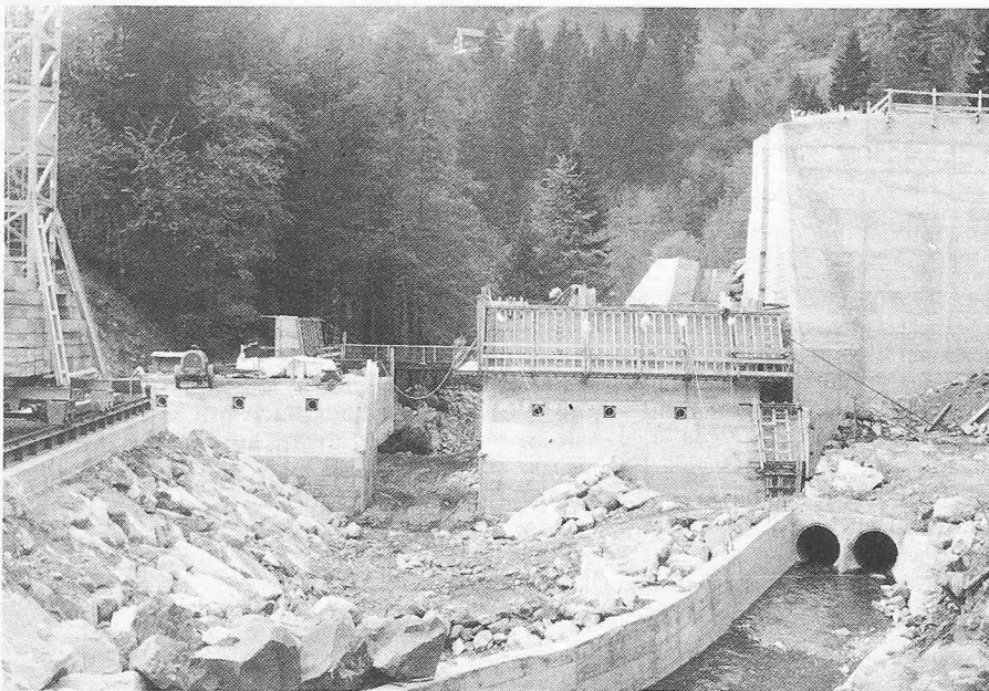
Bild 2. Das Sperrenbauwerk im Bau (12. Mai 1981). Blick aus dem Stauraum bachabwärts. Rechts im Vordergrund erkennt man die beiden Einläufe der Wasserumleitung während des ersten Teiles der Bauzeit (Doppelröhre unter dem rechten Sperrenflügel hindurch)
