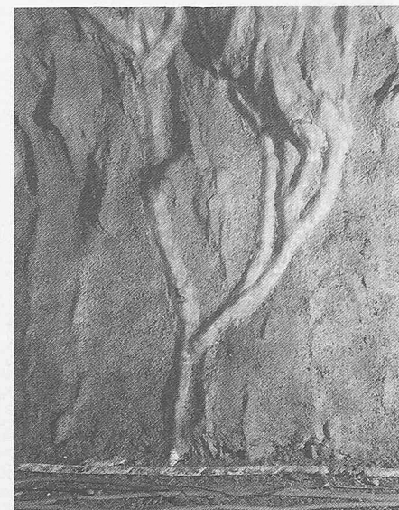
Bild 7. Von Hand angemauerte Drains
