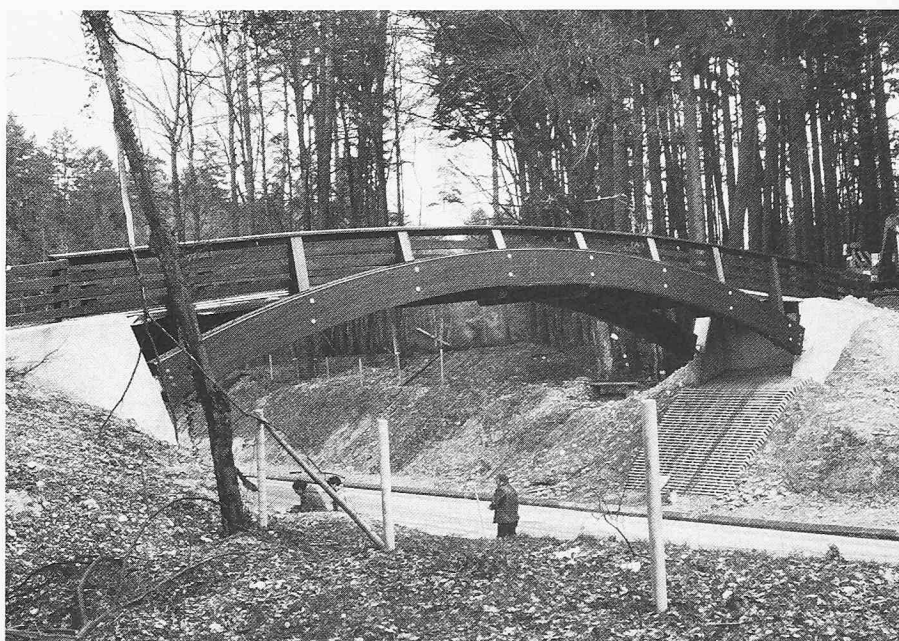
Ansicht der neuen Holzbrücke
