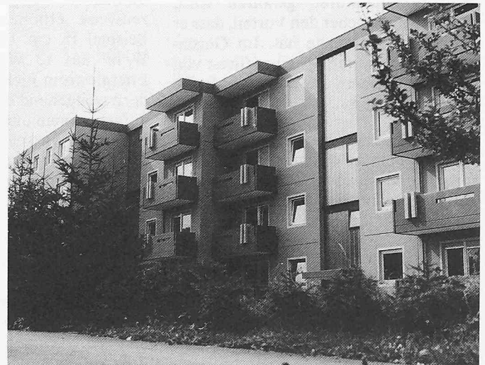
Bild 12. 30-Familien-Haus mit monovalenter Beheizung über ein Massivabsorber-Heizsystem
