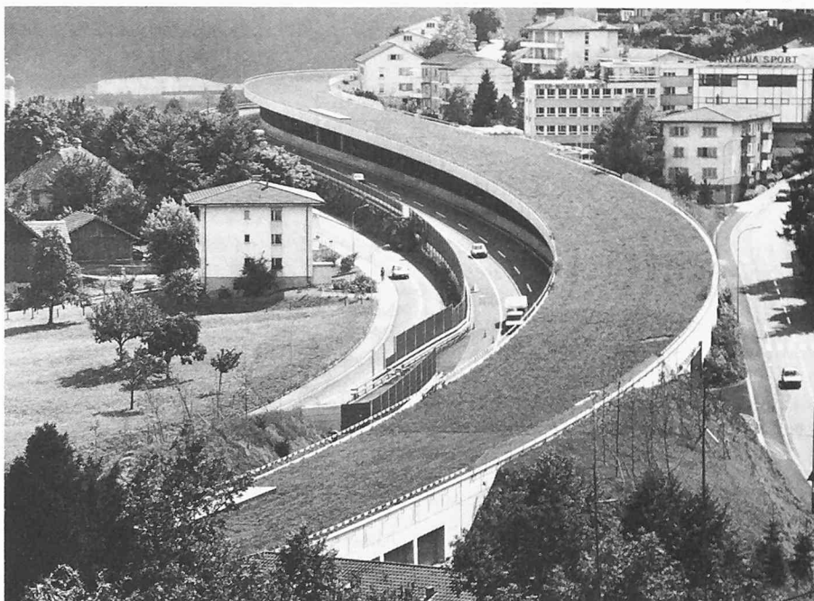
Bild 4. N2. Lärmschutzgalerie Hergiswil. Baulos 60. Blick Richtung Süden
