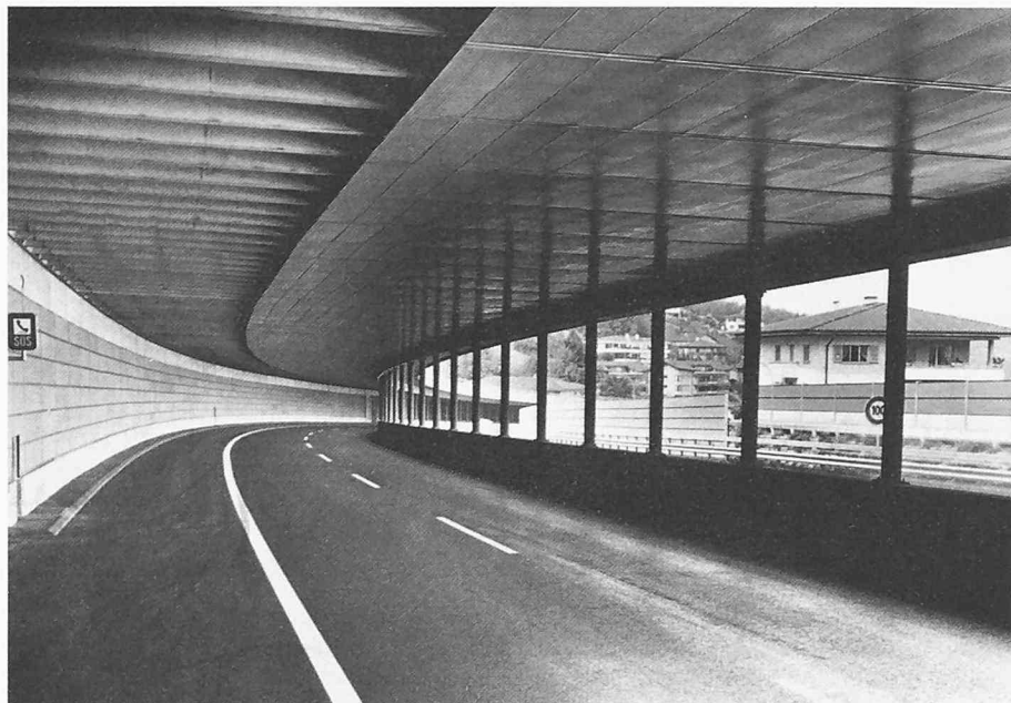
Bild 5. Lärmschutzgalerie (ausgeführt). Innenansicht
