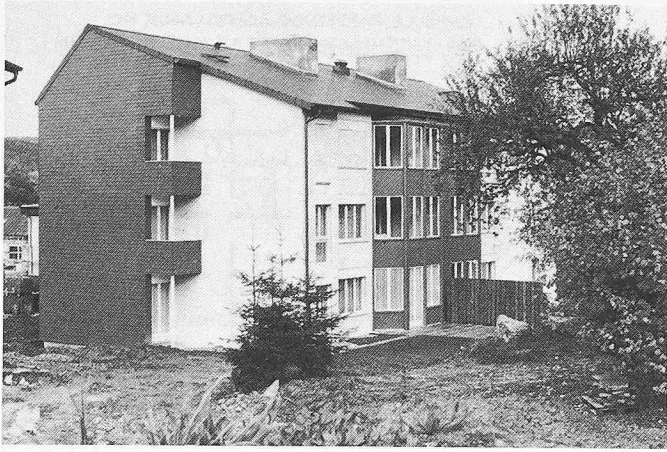
Bild 8. Südfassade mit Wintergarten
