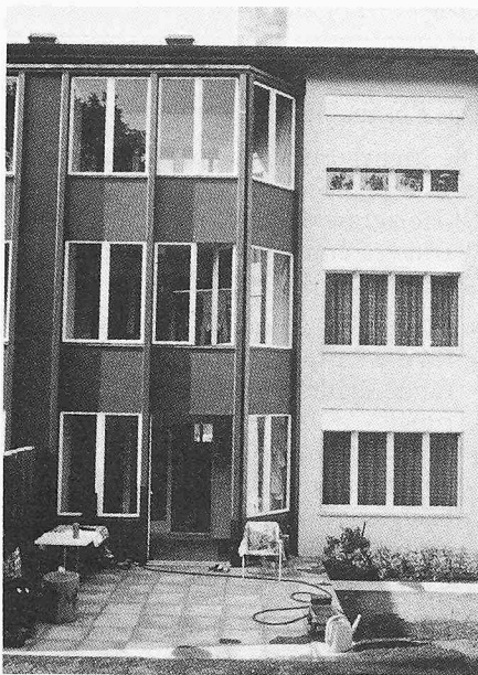
Bild 11. Wintergarten von aussen
