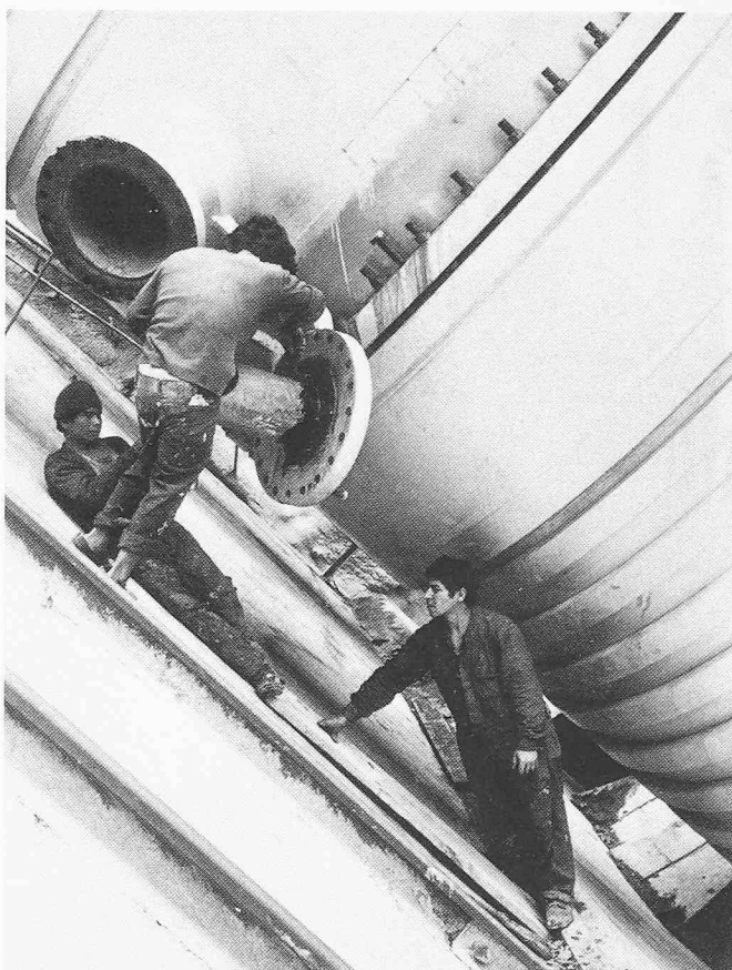
Bild 10. Das Ein- und Aussteigen durch dieses ohnehin zu enge Mannloch ist hier besonders schwierig. Ein gefahrloses Arbeiten an der Druckleitungsexpansion (z. B. Nachziehen der Schrauben über den ganzen Umfang oder Auswechseln der Dichtungsschnüre) ist unmöglich
