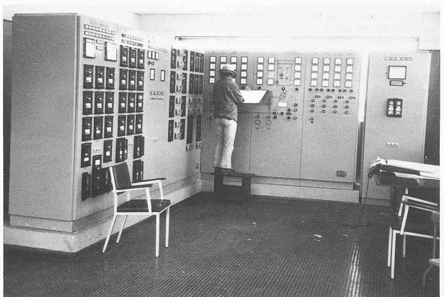
Bild 20. Zu hoch angeordnete Instrumente
