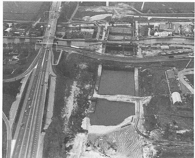
Bild 5. Unterquerung einer Wasserstrasse in den Niederlanden (Qouve-«Aquädukt») (beton 1/81)
